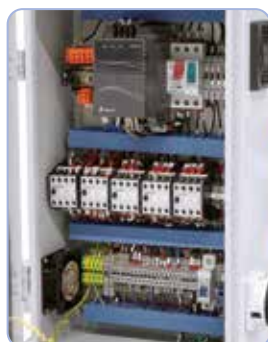
Convertisseur de fréquence pour variation continue de la vitesse de rotation
