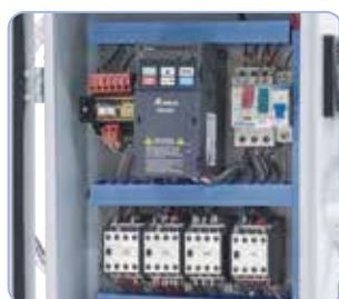
De série avec convertisseur de fréquence
